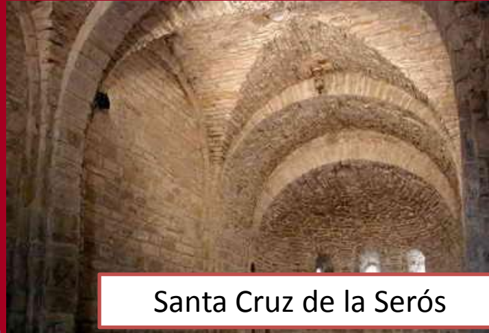
Bóveda de arista
